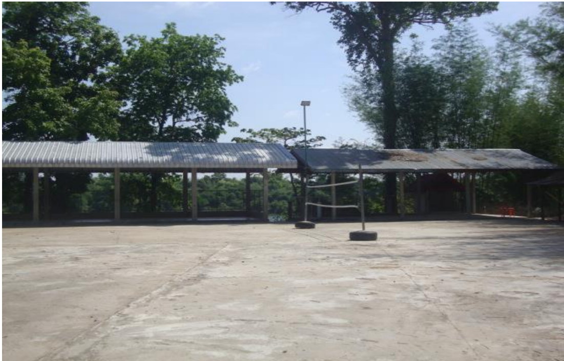
รูปภาพ : ลานกีฬาอเนกประสงค์ของบ้านหินสูง หมู่ที่ ๔
