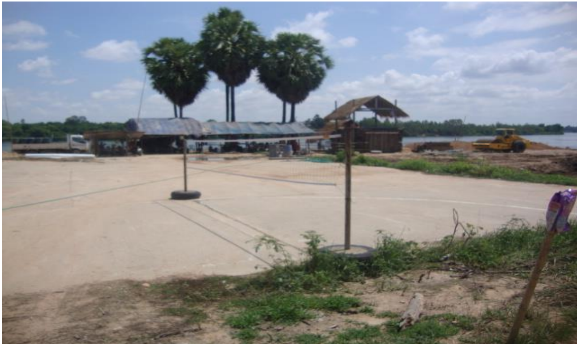
รูปภาพ : ลานกีฬาอเนกประสงค์บ้านหินลาด หมู่ที่ ๖
